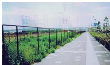
フェンス左側が建設予定地(尼崎市大浜町)
